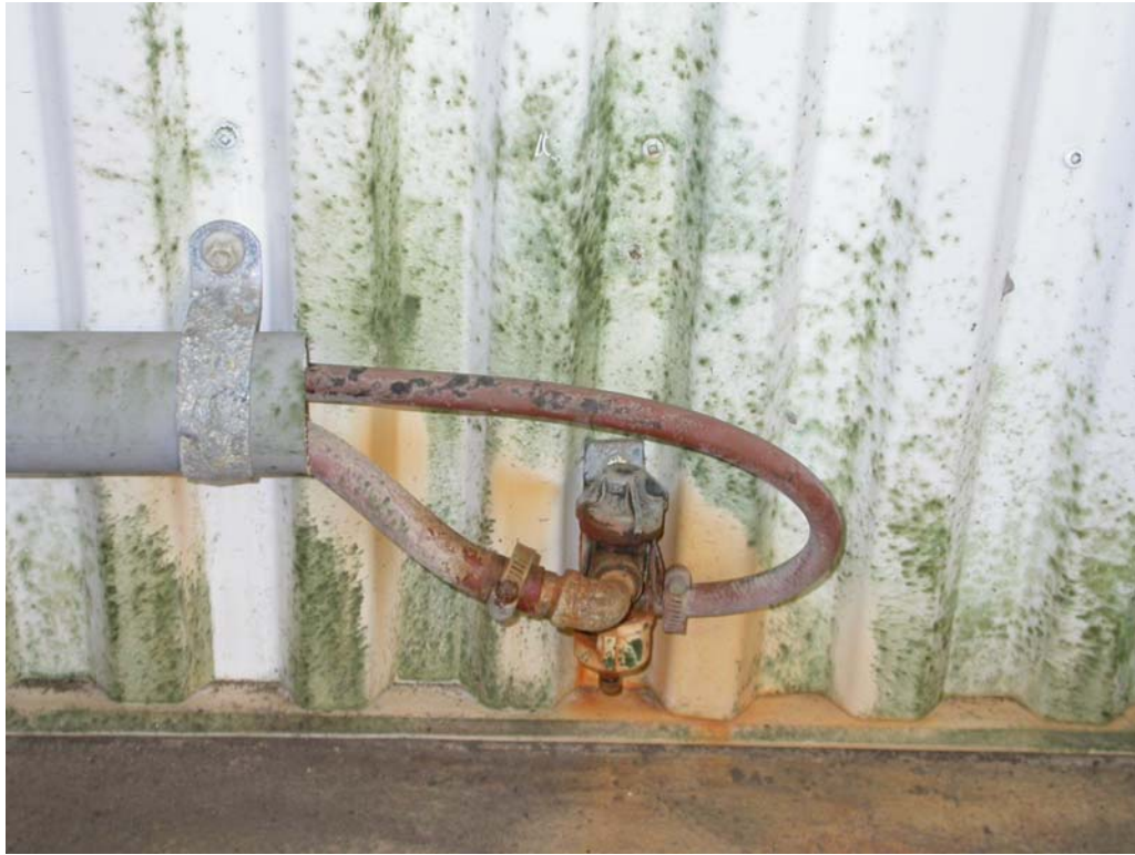
Photo 3. Des buses air-eau comme celle-ci sont utilisées à l'intérieur de la chambre de germination pour produire un brouillard.
